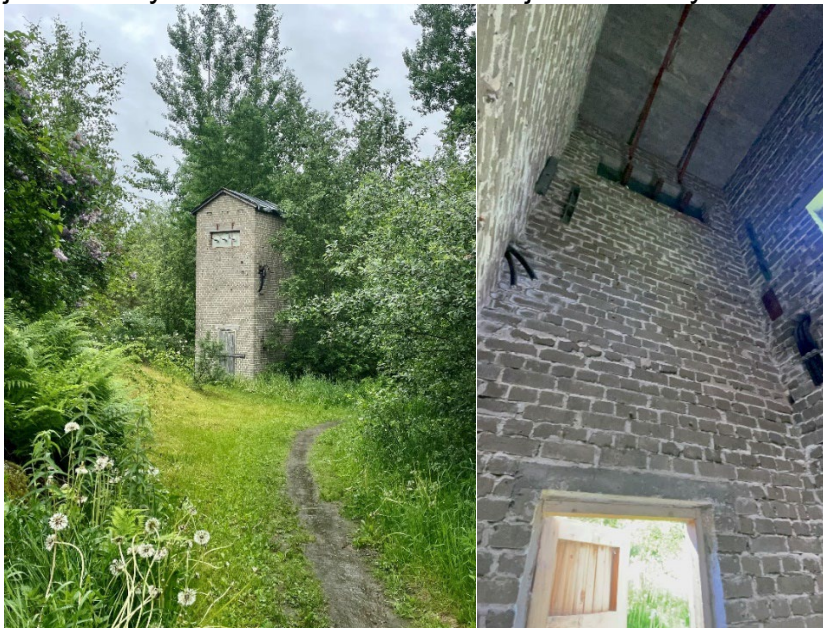
Tornimuuntamorakennus ulkoa ja sisältä kuvattuna.
